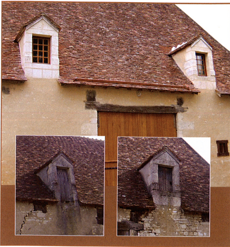
La lucarne gauche a été restituée à l'identique de l'autre. C'est la seule modification opérée sur le bâtiment.
